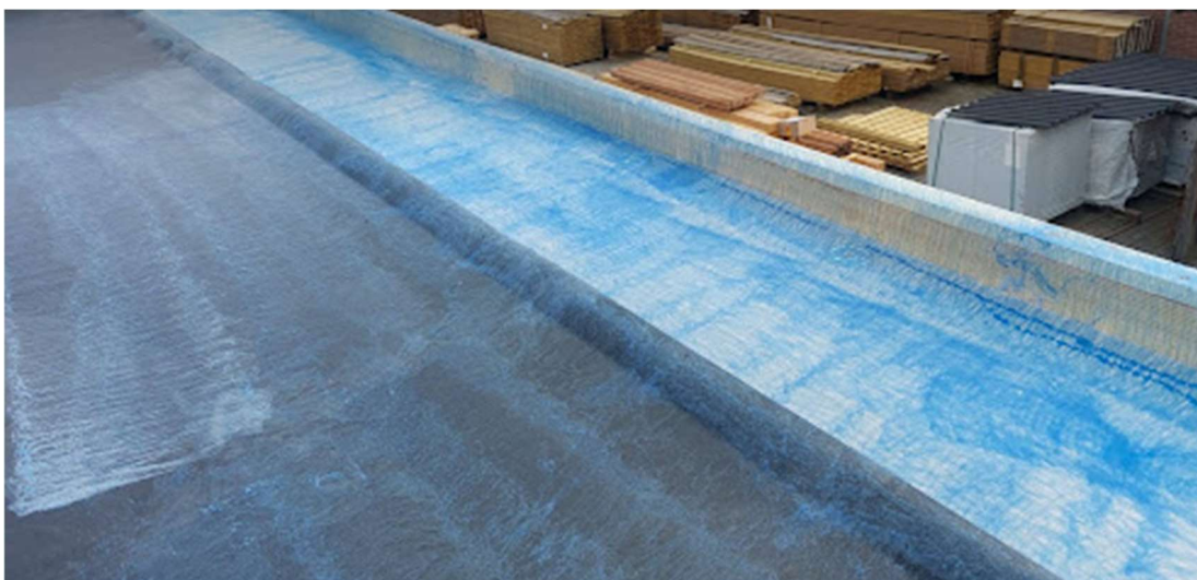
Stap 7: ga kant voor kan verwerken, spuit de opstand en het gedeelte van het epdm in met lijm, en wacht totdat deze weer droog zijn, en ga dan vanuit het midden naar buiten werken. Rol eerst het epdm tegen de kiezel, druk deze goed in de hoek en ga dan omhoog tegen de kiezel aan werken.
